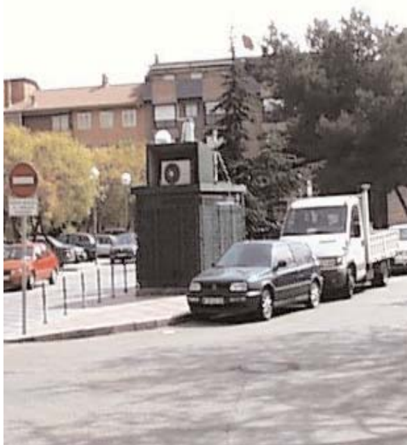
Estación de medida nº 17.
